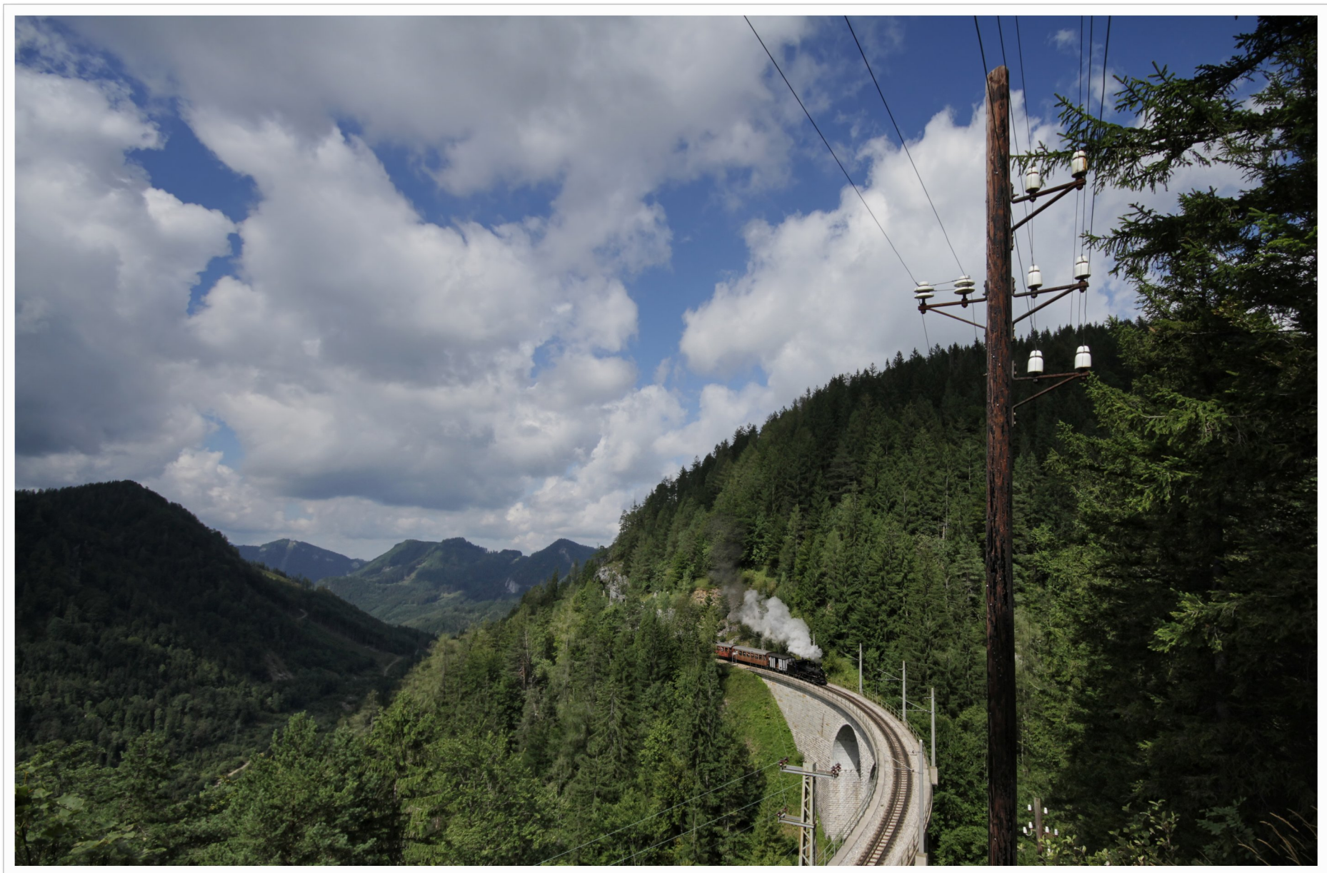
Mh.6, Saugraben Viadukt, 5. 9. 2010
